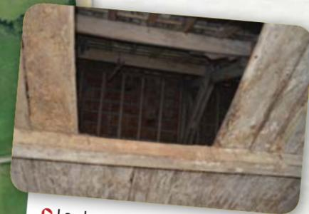
La charpente est constituée de six fermes dont l'état reste à vérifier. Le plancher repose sur des solives qui ne présentent pas toujours le même espacement et ne se trouvent pas exactement aux mêmes niveaux. La toiture n'étant pas isolée, les tuiles sont apparentes.
