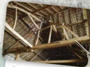
▫ Le volume de la grange est très impressionnant ; la charpente y est intégralement visible. Elle offre un niveau libre à environ quatre mètres sous poutre.
