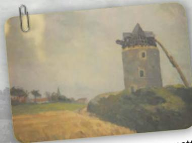
D'anciens documents permettent de reconstituer l'aspect initial du moulin : une pierre grise pour les maçonneries principales et une pierre plus claire ou badigeonnée pour les encadrements de baies et le couronnement. La charpente présentait 2 lucarnes axiales et un bras arrière permettait de diriger les ailes en fonction de l'orientation du vent.
