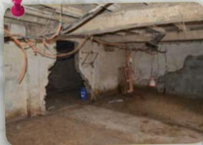
Les murs porteurs de 34cm d'épaisseur sont faits de briques sur lesquelles repose la charpente traditionnelle en bois. La brique d'origine a été partiellement recouverte de mortier et de peinture sur le pignon ouest.
